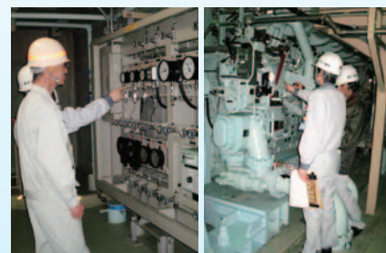
A号機の試験の様子
