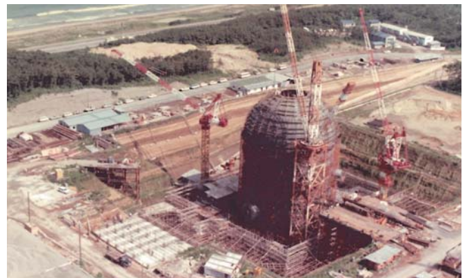
「常陽」格納容器建設（1971.7）
