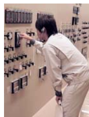
中央制御室内での電磁ポンプ起動操作
