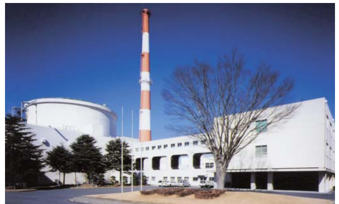
高速実験炉「常陽」
