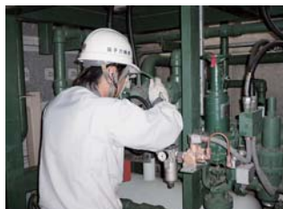
ナトリウム注入のための弁操作の様子
