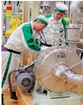
排風機の点検作業
