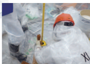
汚染水処理後の二次廃棄物
