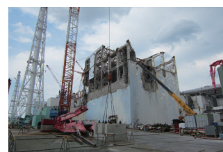
2011年3月11日の東日本大震災で事故を起こした東京電力(株)福島第一原子力発電所。
