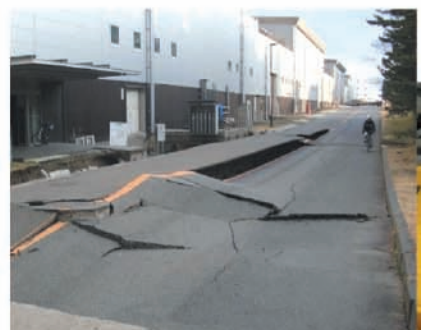
●J-PARC リニアック棟玄関前道路
