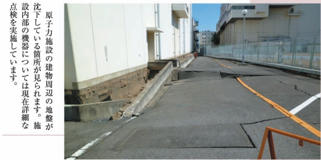
●再処理施設内一部の地盤が0.5m程度陥没。
