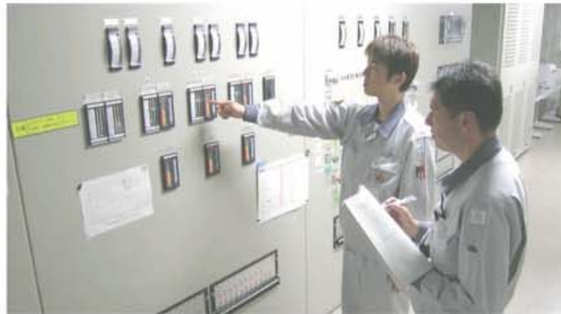
●プラント確認試験の様子
