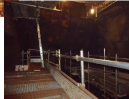
(撮影日 平成25年1月22日 解体撤去後)
