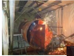
(撮影日 平成25年1月15日 給水加熱器胴解体撤去作業)
