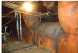
(撮影日 平成25年1月8日 解体撤去前)
