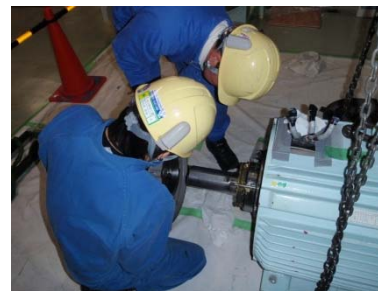
【格納容器(※1)空調設備保守点検】 (撮影日 平成25年1月8日)
