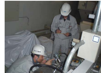
【2次系ナトリウム漏えい検出器点検作業】 (撮影日 平成25年1月11日)
