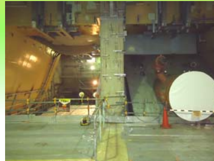
【左/B - 復水器撤去 右/A - 復水器 (地下1階)】 (撮影日 平成24年12月12日)
