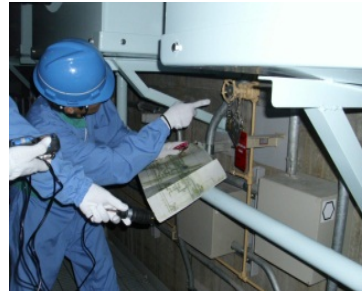
【メンテナンス冷却系設備(※1) 外観据付目視確認】 (撮影日 平成24年10月2日)
