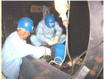
【設備の自主点検 (原子炉補機冷却系(※2)熱交換器水室開放点検)】 (撮影日 平成24年10月23日)
