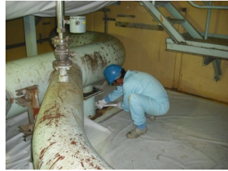
【復水器の解体撤去作業 (解体撤去作業に向けた準備作業／現場養生)】 (撮影日 平成24年9月6日)
