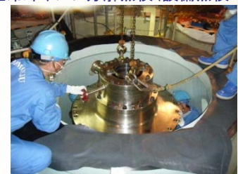
1次主ポンプ軸封部点検(平成22年12月3日)
