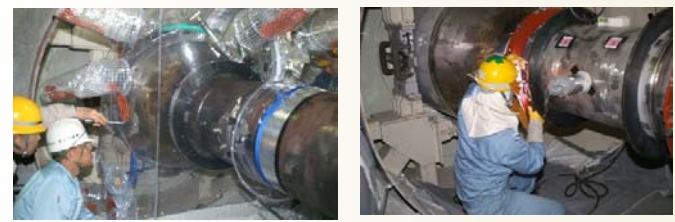
2次主冷却系配管の取替作業(平成17年3月6日) 2次主冷却系配管の新設配管溶接(平成18年4月14日)
