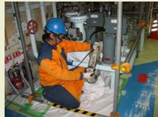
【廃棄物処理設備配管取替作業】 (撮影日 平成24年6月20日)
