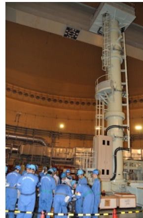
【新しく製作した炉内中継装置の 原子炉容器内への据え付け】 (撮影日 5月28日)
