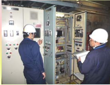
【補助蒸気設備計装品自主点検】 (撮影日 5月9日)
