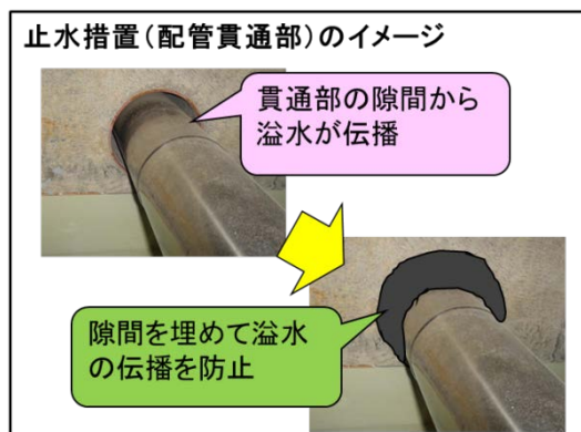
図 3.6-2 止水措置（配管貫通部）イメージ
