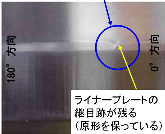
実機外観写真90° 方向に残る凸に見える部分
