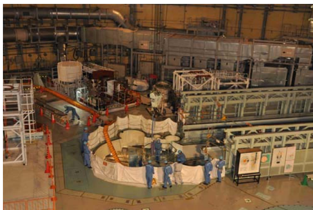
平成23年11月7日 14時30分頃の作業風景
