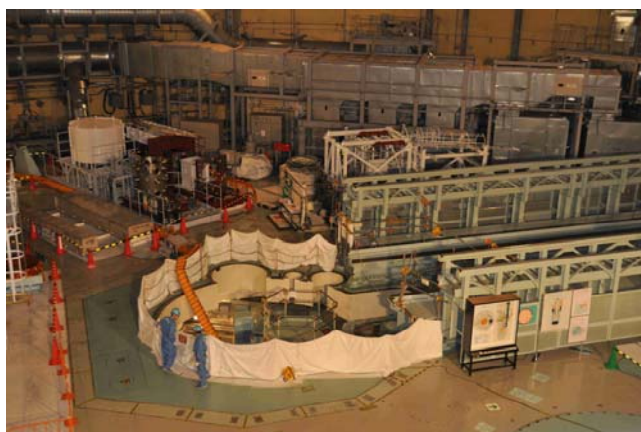
平成23年11月 4日 14時30分頃の作業風景
