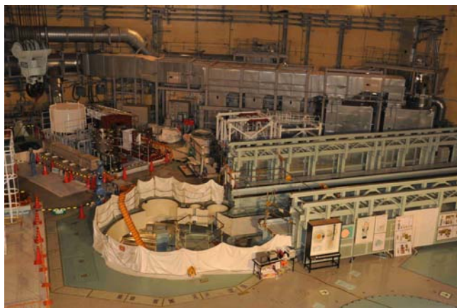
平成23年11月 2日 14時30分頃の作業風景
