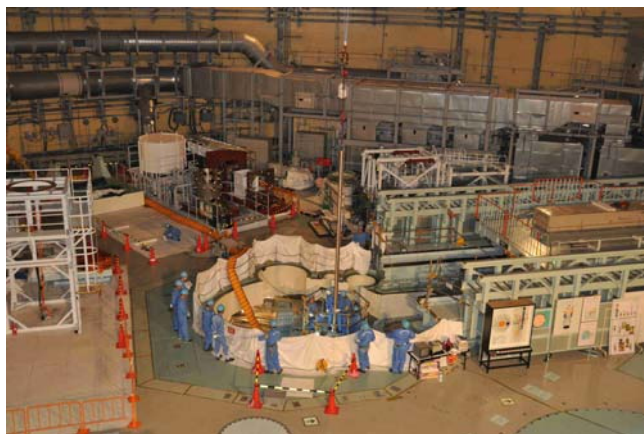
平成23年11月 1日 14時30分頃の作業風景
