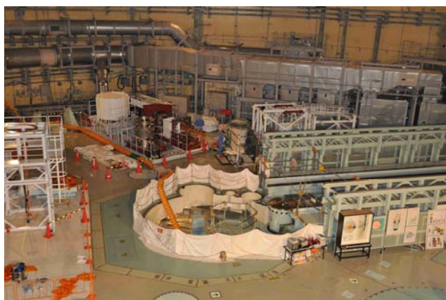
平成23年10月28日 15時頃の作業風景
