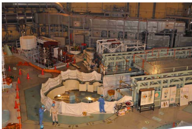
平成23年10月25日 15時頃の作業風景
