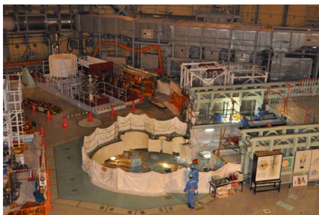
平成23年10月20日 14時30分頃の作業風景
