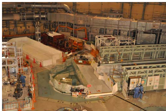
平成23年 9月30日 15時頃の作業風景
