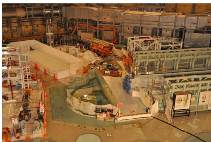
平成23年 9月16日 15時頃の作業風景
