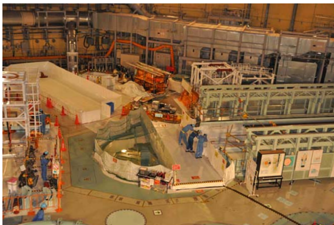
平成23年 9月15日 15時頃の作業風景
