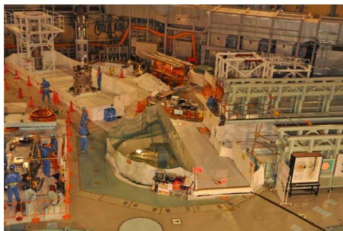
平成23年 9月13日 15時頃の作業風景
