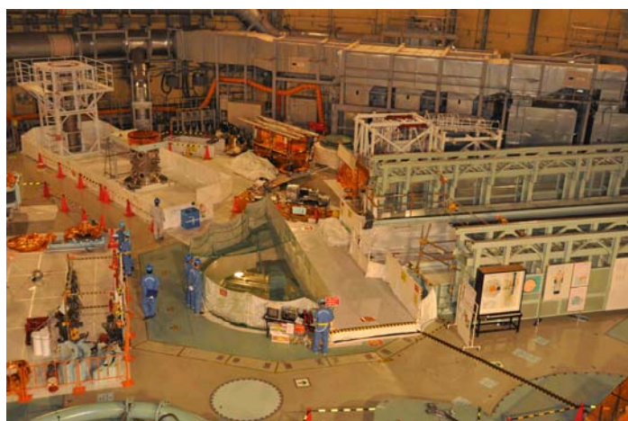
平成23年 9月12日 15時頃の作業風景
