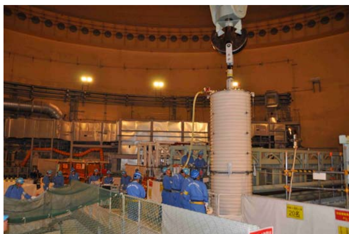
平成23年 9月 9日 15時頃の作業風景
