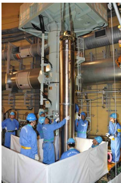
平成23年 9月 8日 11時30分頃の作業風景
