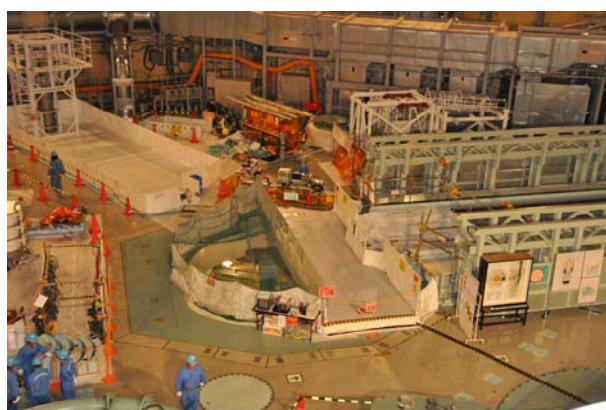
平成23年 9月 8日 15時頃の作業風景
