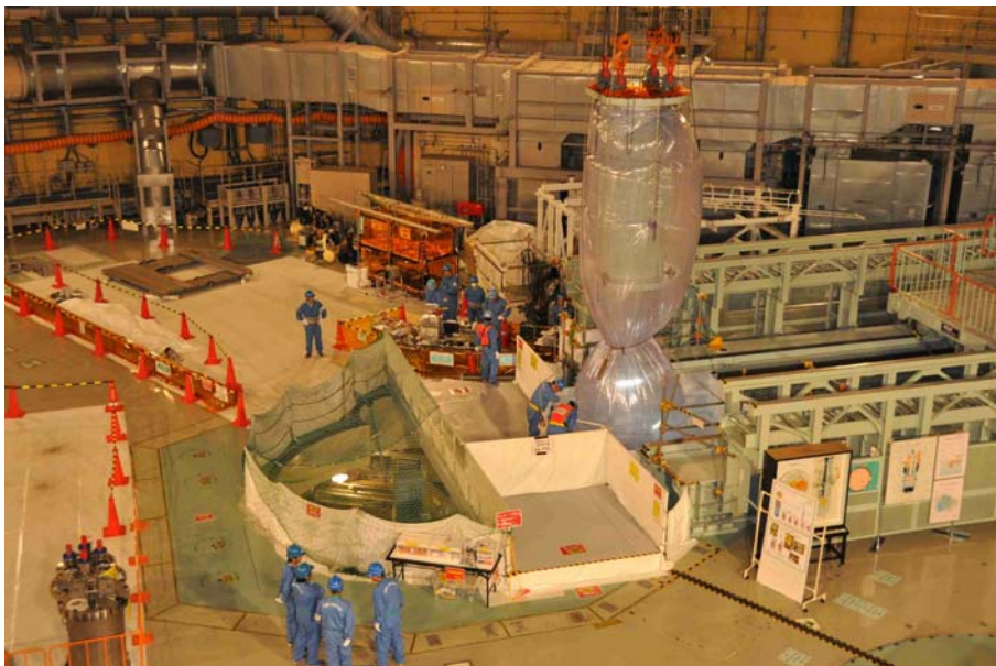
平成23年 6月 6日 14時頃の作業風景
