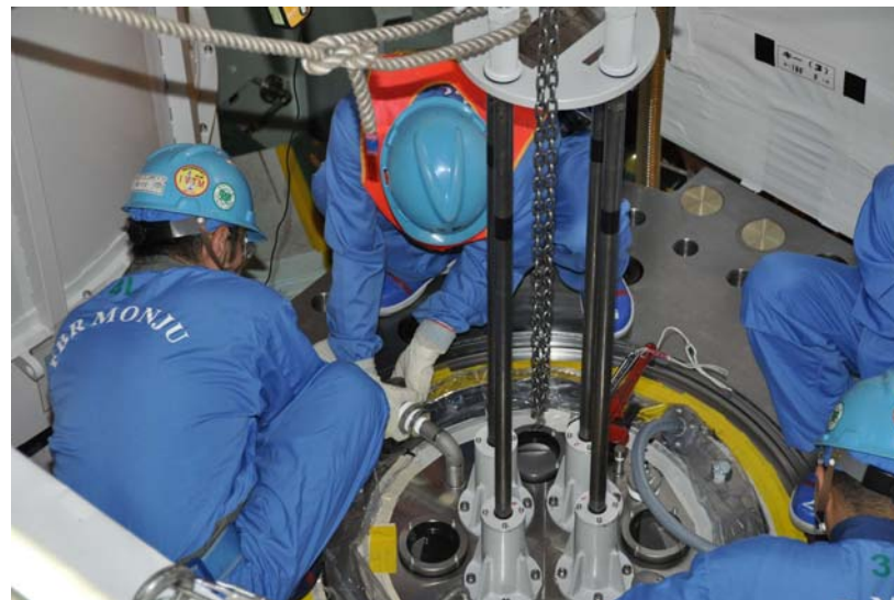
上部案内筒閉止プラグ設置作業 (平成23年5月25日撮影)
