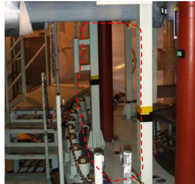
バルブスタンド取外し後
