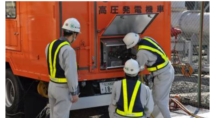
電源車のつなぎ込み訓練状況
