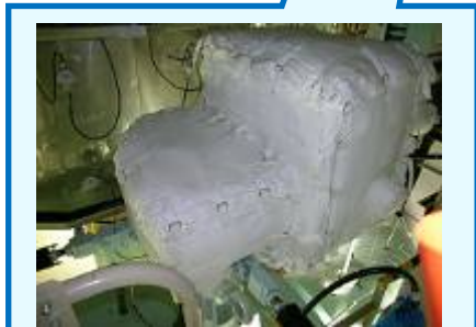
蒸気発生器入口止め弁
