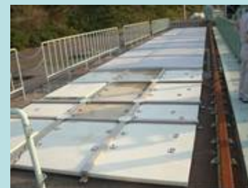
取水口の海水配管通路の上部蓋部 (海拔+5m)
