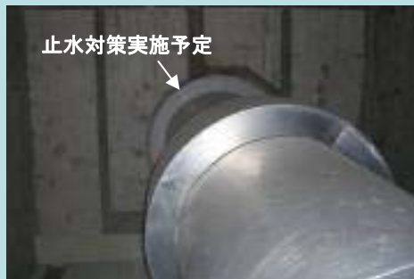
海水配管通路の敷設状況 (海拔+10.3m)
