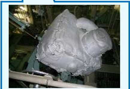
空気冷却器出口止め弁
