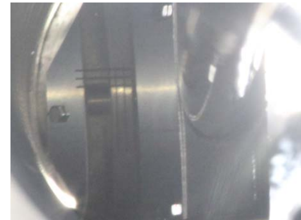
内側案内管上部-247.5° 方向
