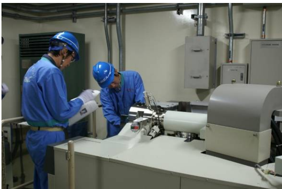
（破損燃料検出装置の試験前点検の様子）
