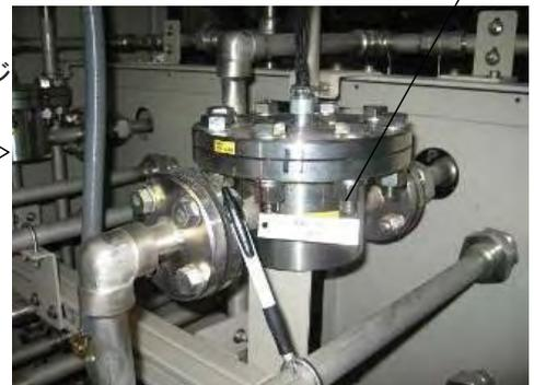
ボルトによるフランジ締め付け
