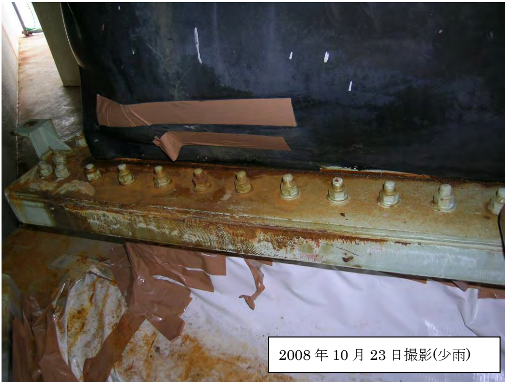
写真 3-1 ダクト側フランジ上部及び側部の水流れ痕跡(着色及び錆の状況)
