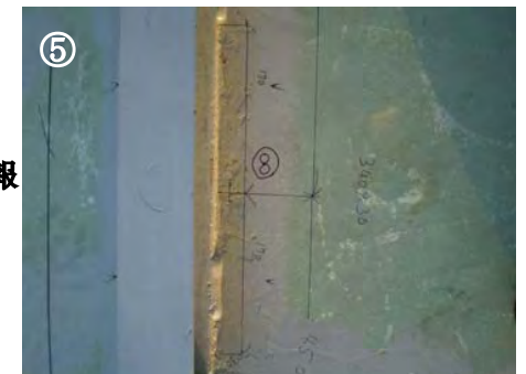
補強材 断続すみ肉溶接部
