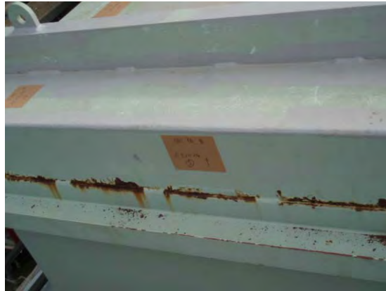
写真 1-1 補強材の断続すみ肉溶接様相
