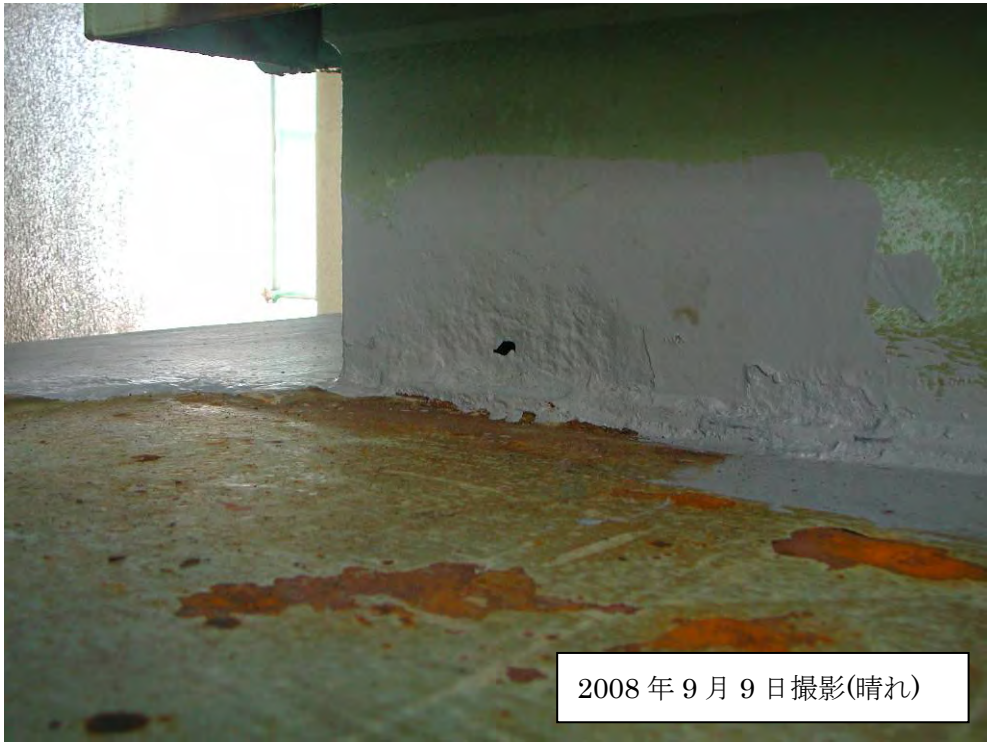
写真 4-2(1) 最初の貫通孔発見時の様相(ペイント塗装途中)
