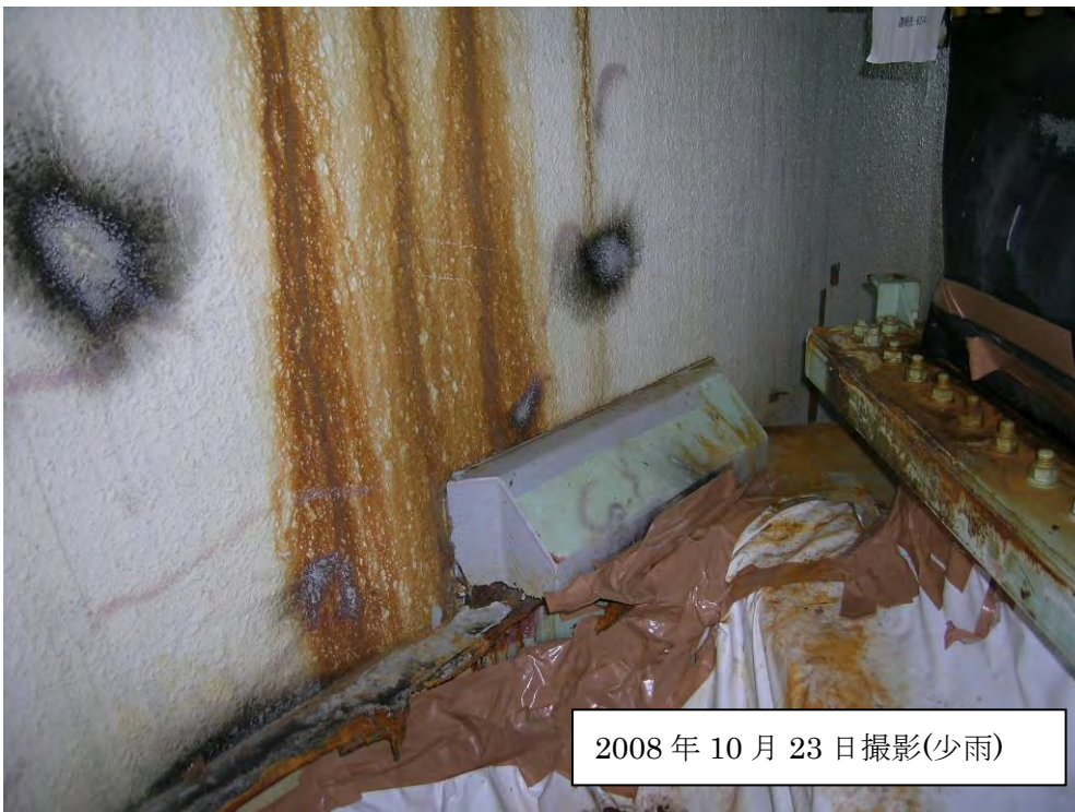
写真 3-2 ダクト近接(相対)部からの水流れ痕跡(着色の状況)
