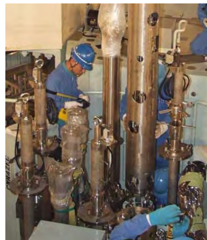
制御棒駆動機構の点検状況
