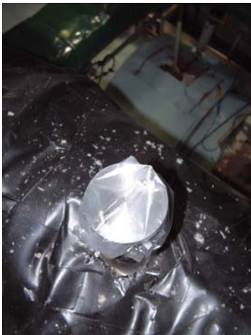
仮の栓取付状態 (過熱器側)
