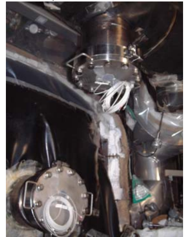
仮の閉止板 取付状態
