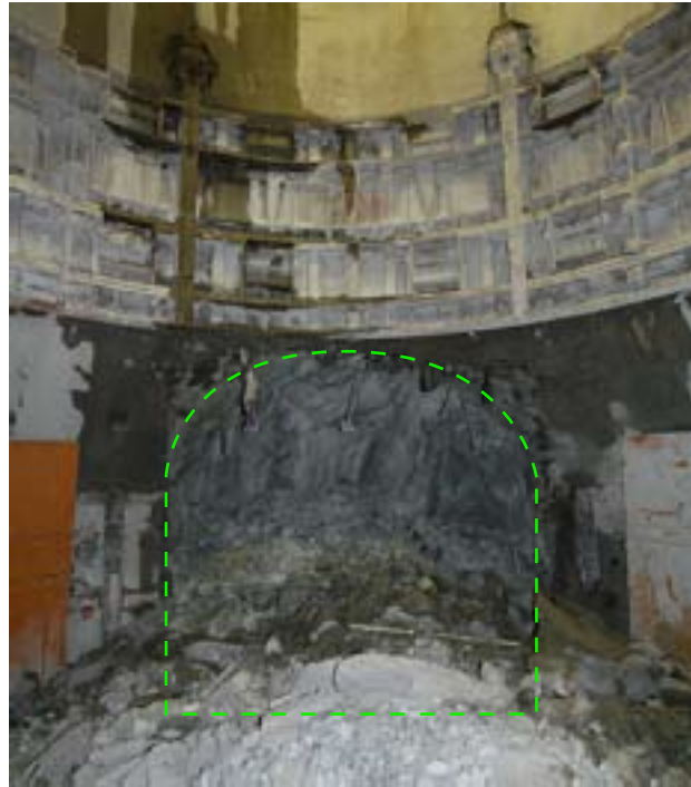
水平の坑道の掘削直後の様子（主立坑、深度300m）
