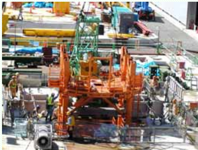
主立坑への搬入の様子
