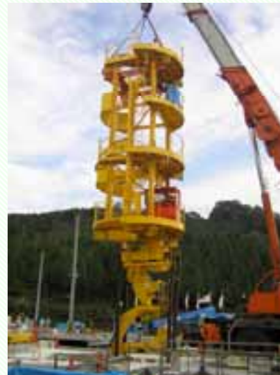
換気立坑への搬入の様子
