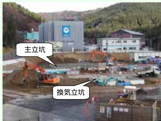
坑口部分の基礎工事の様子
