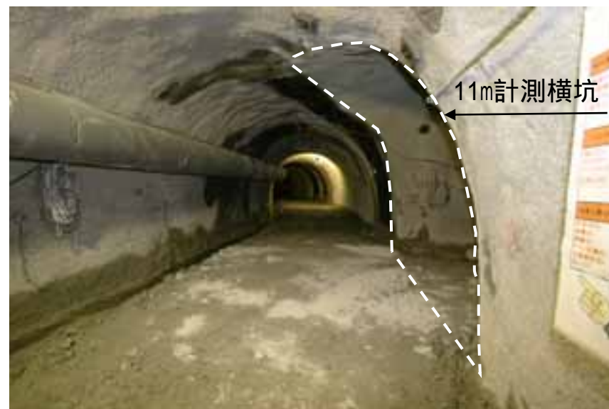
【深度300m調査研究用の水平坑道】
