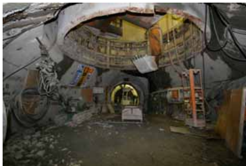
【主立坑坑底（深度300m）】
