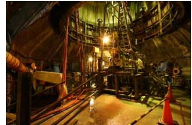
【名古屋大学】 （ひずみ計等の設置） （平成19年度実施）
