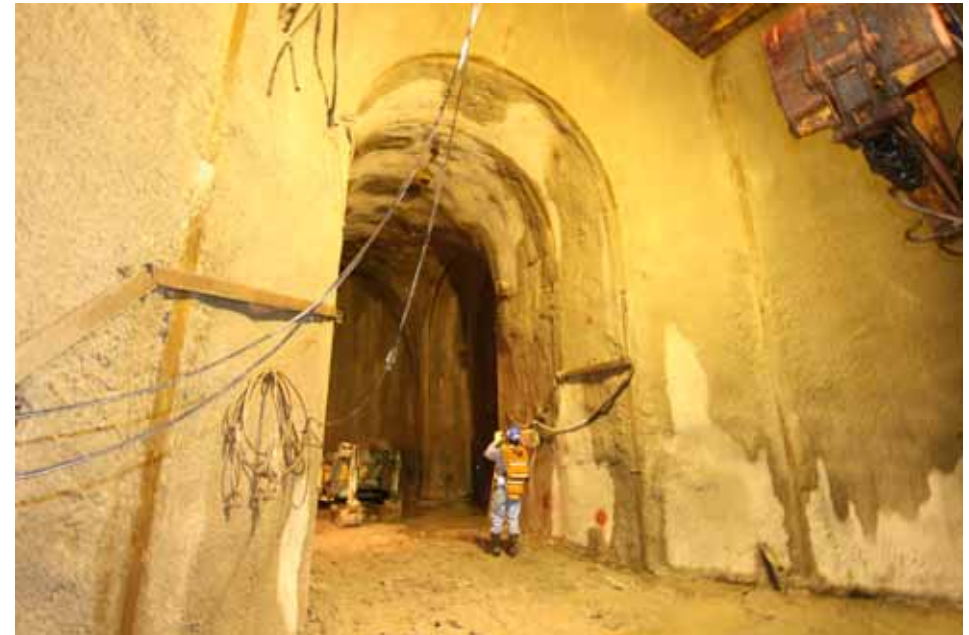
換気立坑側のボーリング横坑
