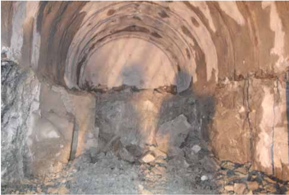
主立坑側のボーリング横坑
