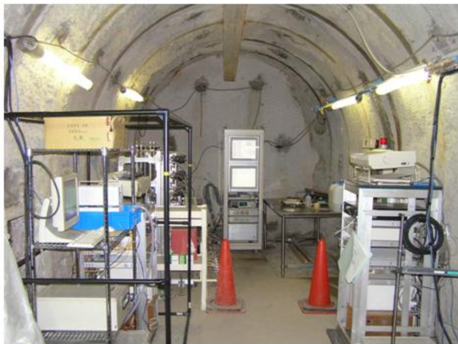
地下水の観測装置
