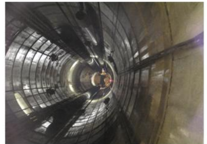
主立坑 (160m地点から坑口を望む)
