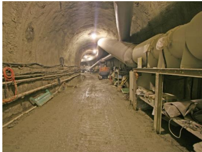
図 2-3 坑道掘削技術の確立（瑞浪超深地層研究所の例、深度 500m 研究アクセス北坑道）
