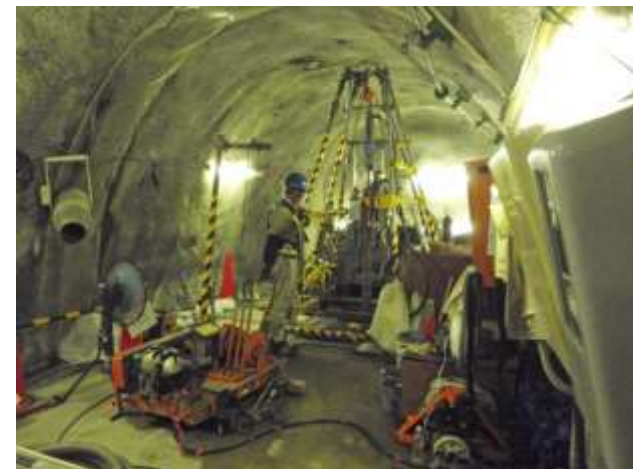
東濃地震科学研究所における応力計の設置 (深度300m研究アクセス坑道 11m計測横坑)
