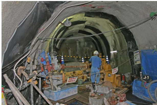
【初期応力測定ボーリング孔】 (平成24年度掘削)
