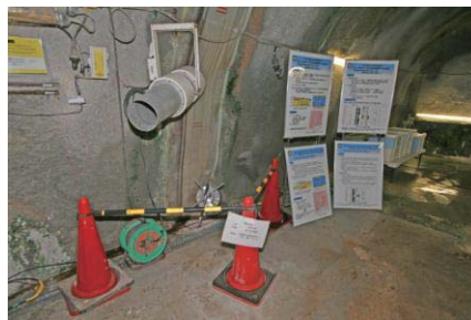
深度 300m 研究アクセス坑道 11m 計測坑道
